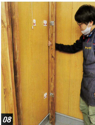
寸法を測り、木材の取り付け位置を決めたら同様の手順で樹脂プレートを壁に固定していく
