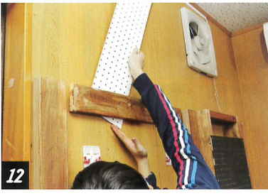
12 設置場所によってはピン押し工具がレバーに届かない。そんなときは、薄い板材をすき間に入れてレバーは押しつけてロックをかけよう
