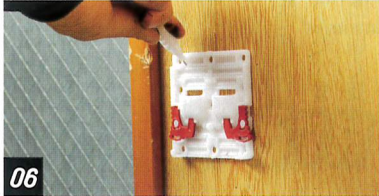
付属のピンで樹脂プレートを固定する。今回の施工現場は薄い化粧合板の壁だったが、厚さ3mm程度だったのでピンでも固定することができた
