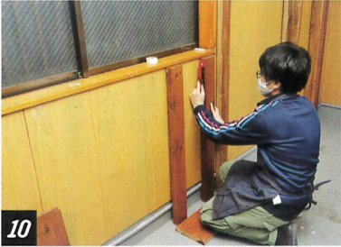
10 木材をカットし、同様の手順で窓下にも柱を立てる
