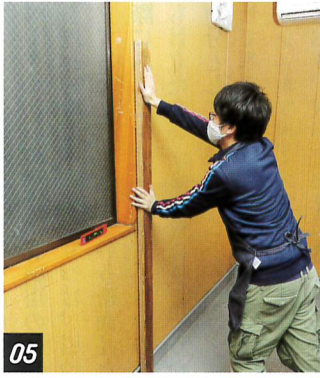
木材を押しつけて樹脂プレートを壁に仮固定
